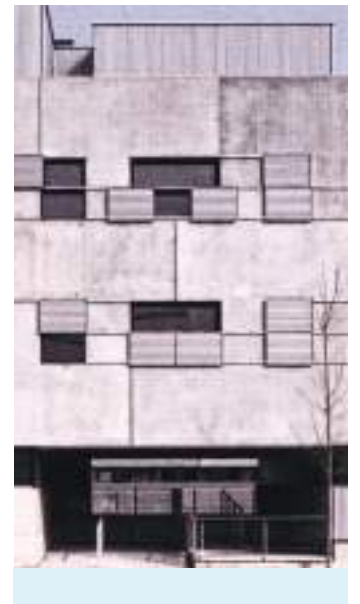
مبنى سكن عمال مدينة مدريد - اسبانيا شكل يوضح طريقة معالجة الخزانات العلوية ودمجها كعنصر من عناصر المبنى
